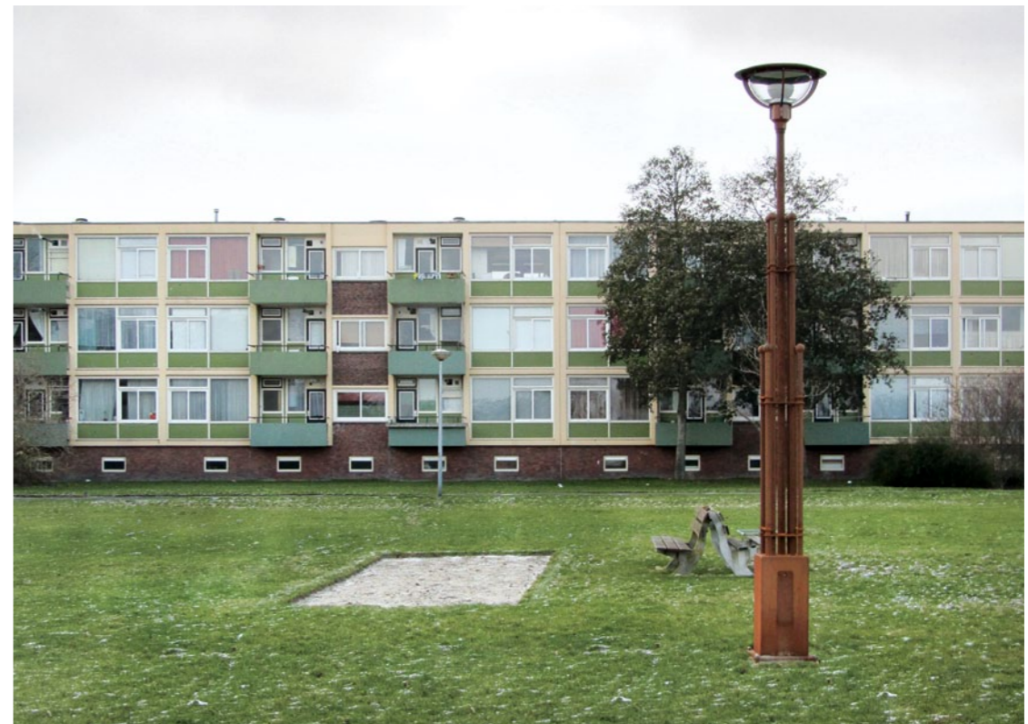
Lichtmast met armatuur
