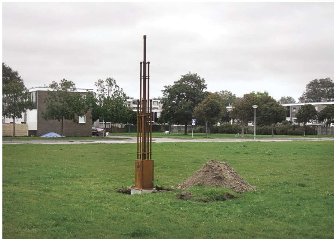
Lichtmast zonder armatuur
