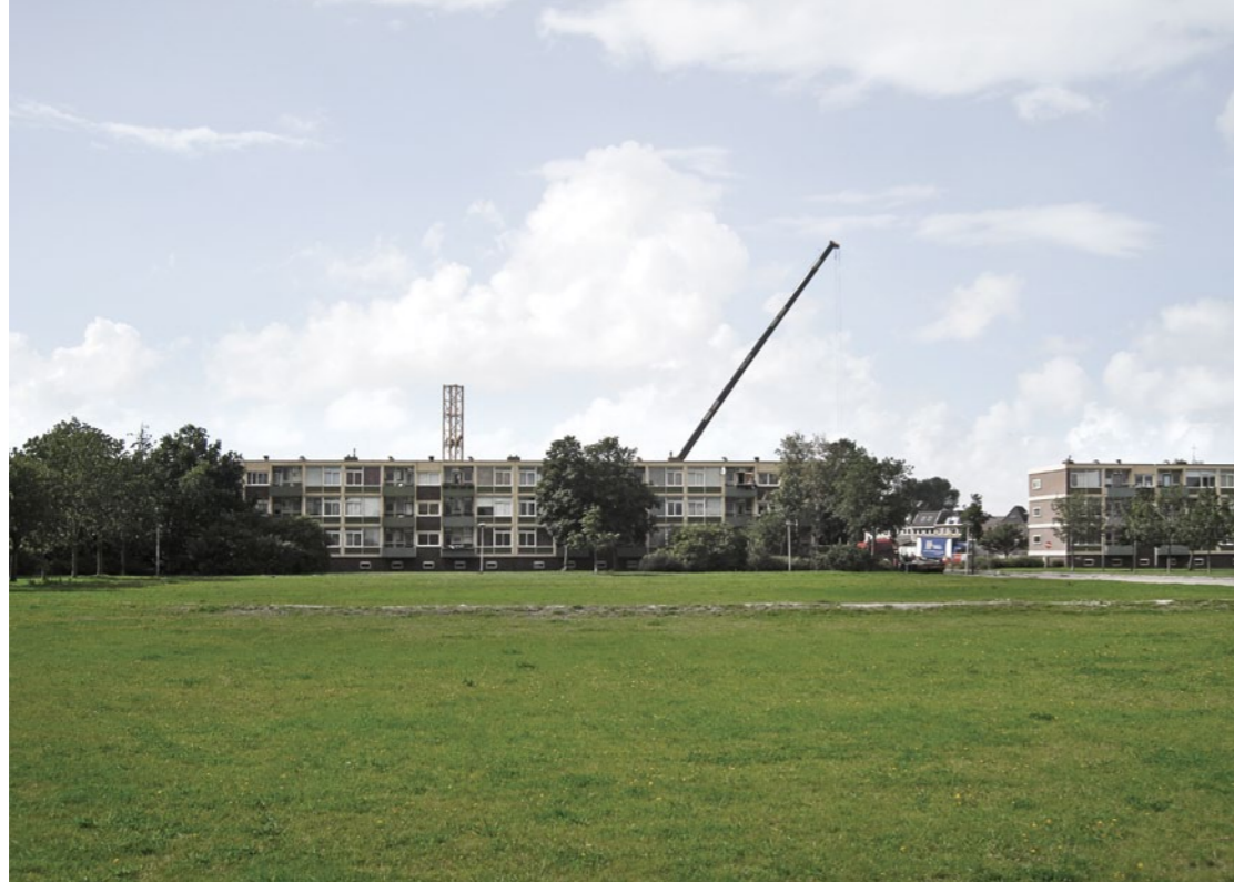
Nieuw Den Helder; Eendrachtstraat, ruimte na sloop
